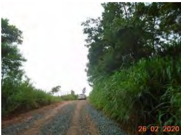
Foto 47 – Percurso percorrido em área de influência do empreendimento. (Data: 26/02/2020)
