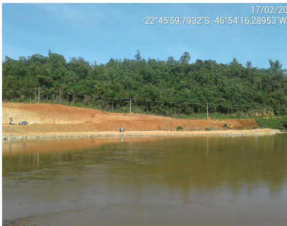
Figura 4: Vista do ponto amostral IC03, evidenciando atividades das obras para a implantação da barragem
