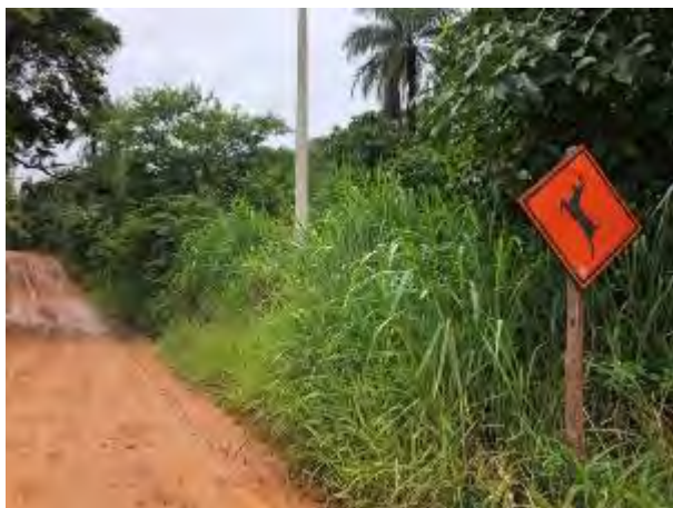
Foto 65 – Sinalização de fauna no caminho de serviço. (Data: 15/01/2020)
