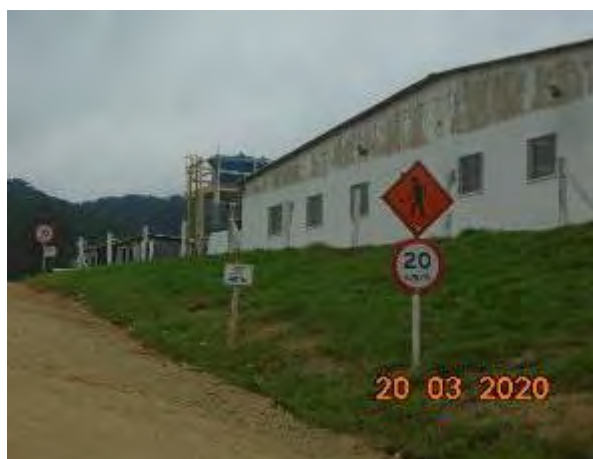
Foto 67 – Sinalização de velocidade. (Data: 20/03/2020).
