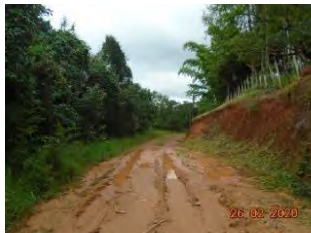
Foto 46 – Percurso percorrido em toda área de intervenção direta ao empreendimento. (Data:26/02/2020)
