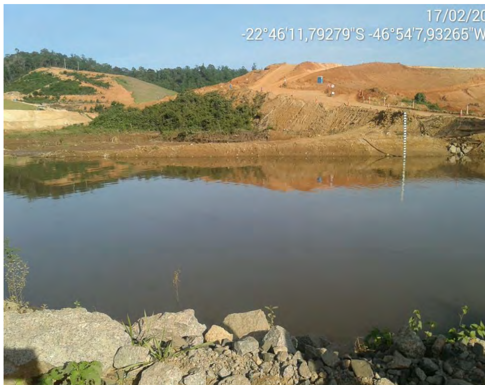
Figura 3: Vista do ponto amostral IC02, destacando o avanço das obras na margem do rio
